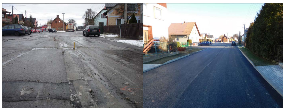
Oprava silnice v Jamnici před a po
